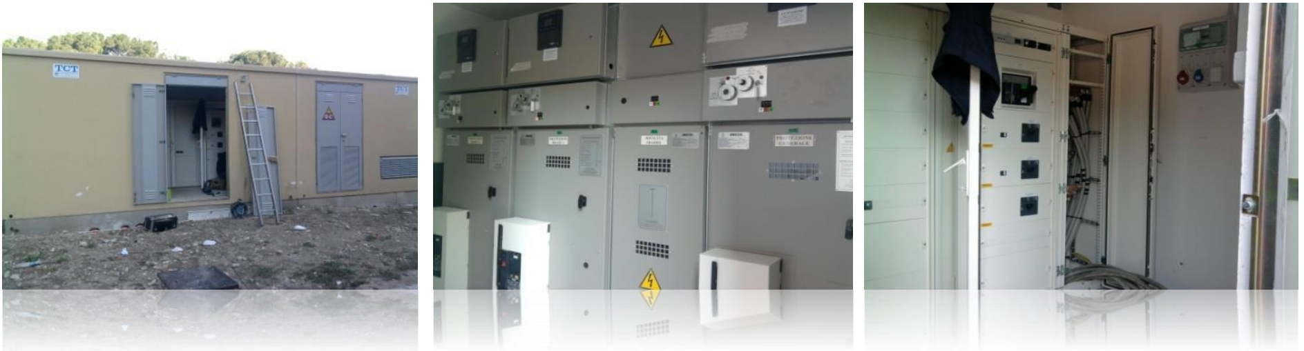
Montaggio cabina in MT- BT ospedale psichiatrico (FG) Anno 2009
